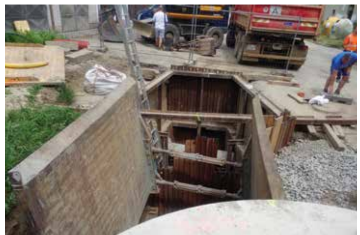
Silně zahlubněný a poměrně složitý objekt „přečerpačky“
